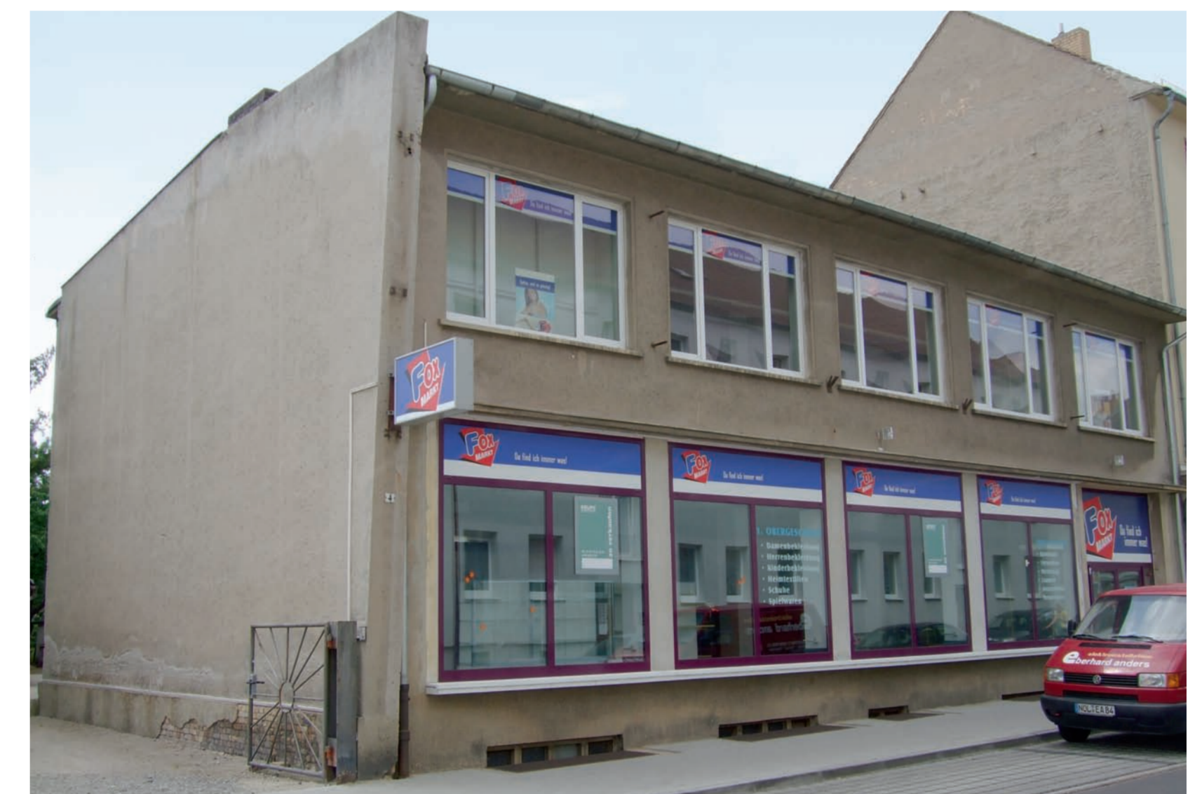
Schmiedestraße 4 – Wiederbelebung durch Geschäftsverlagerung einschließlich Sanierung
